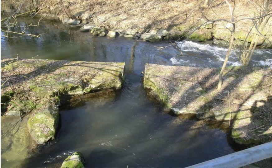
Die FAH Sassbach wurde zur Herstellung der Durchgängigkeit des Sassbaches hergestellt. Im Bereich der FAH Sassbach weist die Dotationsöffnung zwischen dem Mühlbach und der FAH eine Breite von etwa 0,6 m auf. Zum Zeitpunkt der Begehung wurde eine Wassertiefe bei der Öffnung von 0,7 m gemessen. Gemäß einer Abschätzung gehen hier je nach Wasserstand im Mühlbach zwischen 0,2 und 0,8 m<sup>3</sup>/s verloren.
