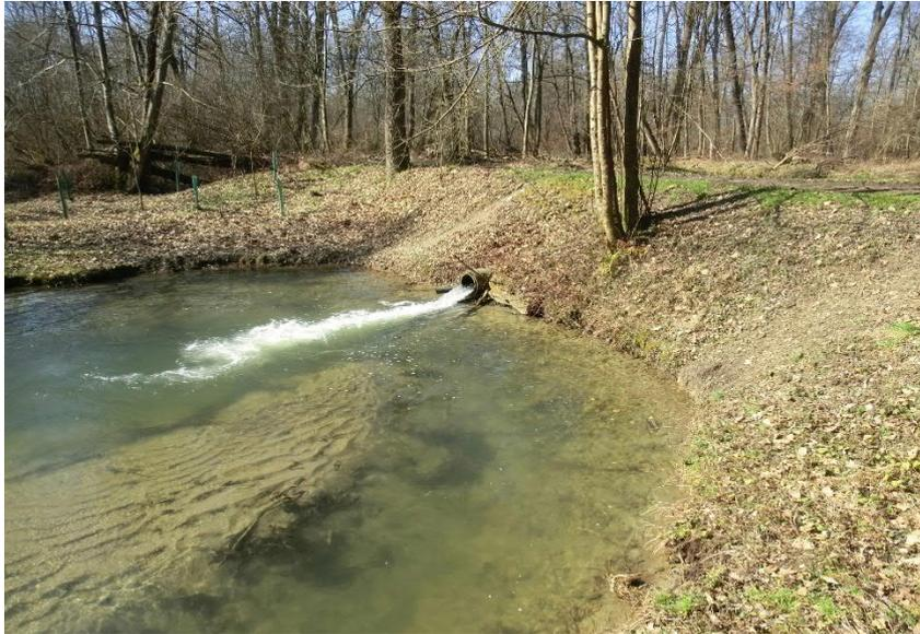
Im Bereich der Ausleitung in den Langwiesenbach besteht eine Verbindung mittels einer Verrohrung DN 300. Bei höheren Wasserständen im Mühlbach gehen hier zwischen 300- 400 l/s verloren. Durch Verringerung des Durchmessers der Verrohrung kann auch hier eine Verbesserung geschaffen werden.
