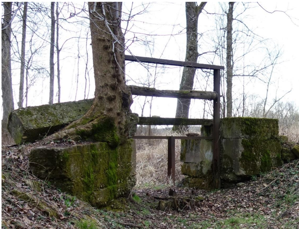
Slika 11: Razdelilni objekt na bifurkaciji obeh iztočnih delov potoka pri Segovcih (foto: Gašper Zupančič, 4.3.2020).
