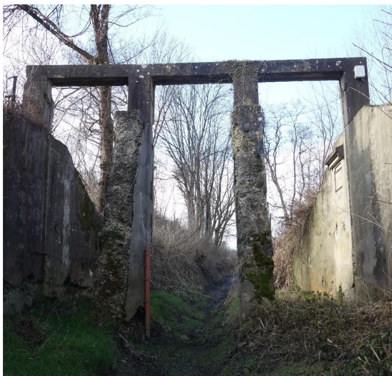
Slika 10: visokovodni objekt - pogled iz dolvodne smeri (foto: Gašper Zupančič, 5.2.2020).
