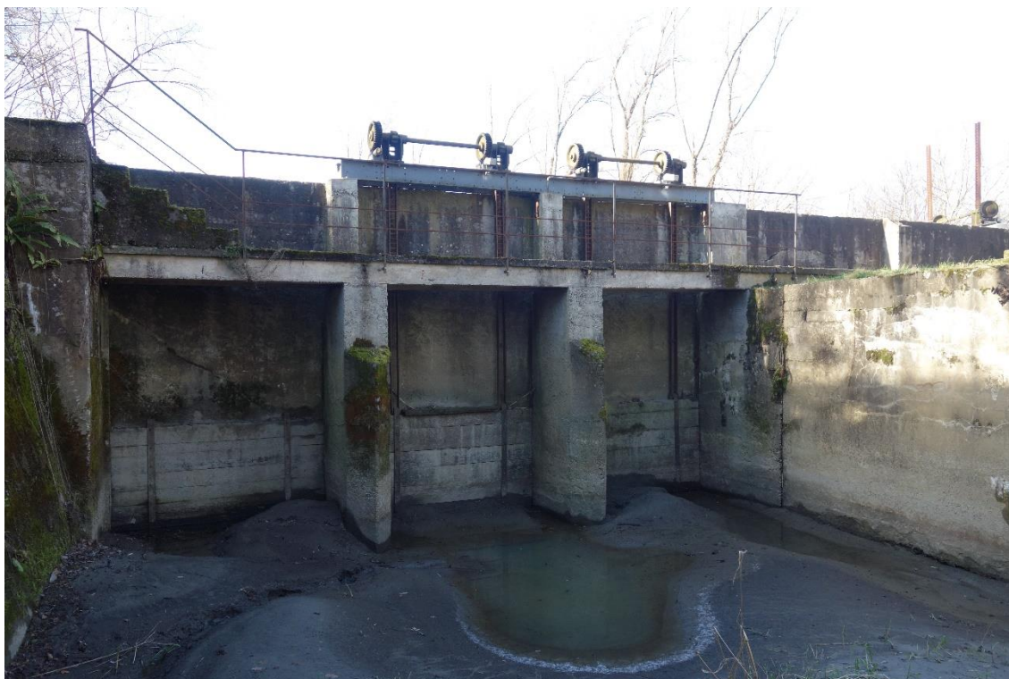
Slika 9: Zapornični objekt na vtoku v potok – pogled iz struge Enajstmilinskega potoka (foto: Gašper Zupančič, 5.2.2020).
