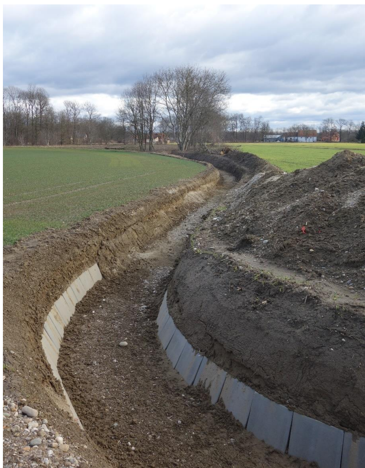
Slika 13: izkop novega kanala mimo meandra Žiberci (foto Gašper Zupančič, 5.2.2020).
