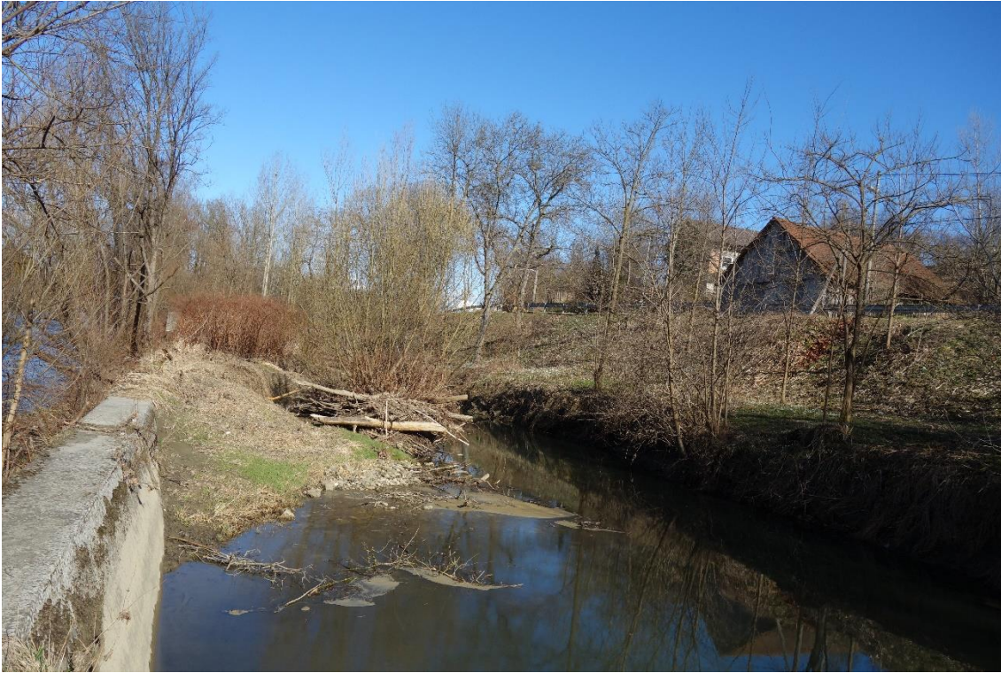
Bild 8: Ablagerungen im Einlaufkanal (Foto: Gašper Zupančič, 27.2.2020).
