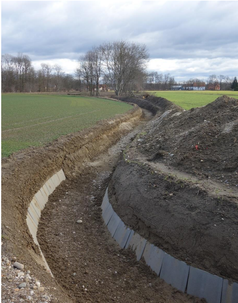
Bild 13: Aushub des neuen Kanals, vorbei am Mäander in Žiberči (Foto Gašper Zupančič, 5.2.2020).
