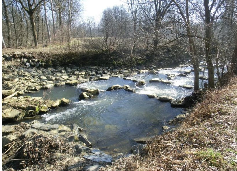
Abbildung 14: Rampenbauwerk zur Dotation des Murarmes
