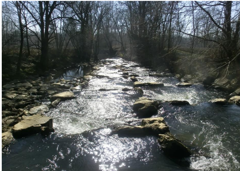
Abbildung 15: Rampenbauwerk zur Dotation des Murarmes
