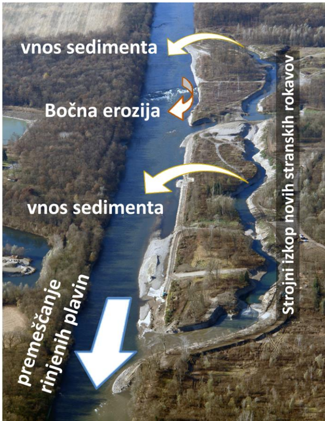
Slika 14. Izvedena širitve Mure pri Gosdorfu s komponentami ukrepa (Habersack et al., 2008).
