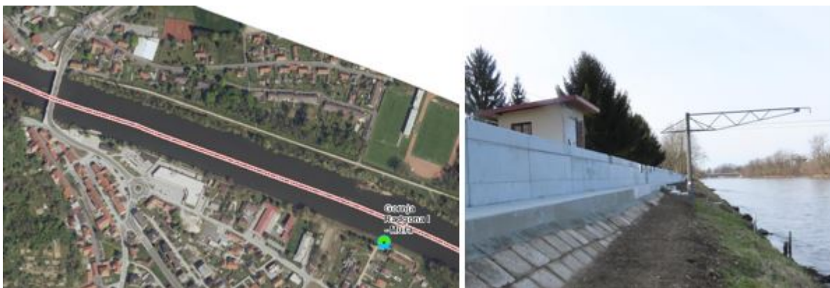
Slika I.3: Kartografski prikaz lokacije vodomerne postaje Gornja Radgona I (levo) (vir: Atlas okolja, 2020); Vodomerne postaje Gornja Radgona I po obnovi protipoplavnega zidu (desno) (vir: Arhiv ARSO, 2020).
