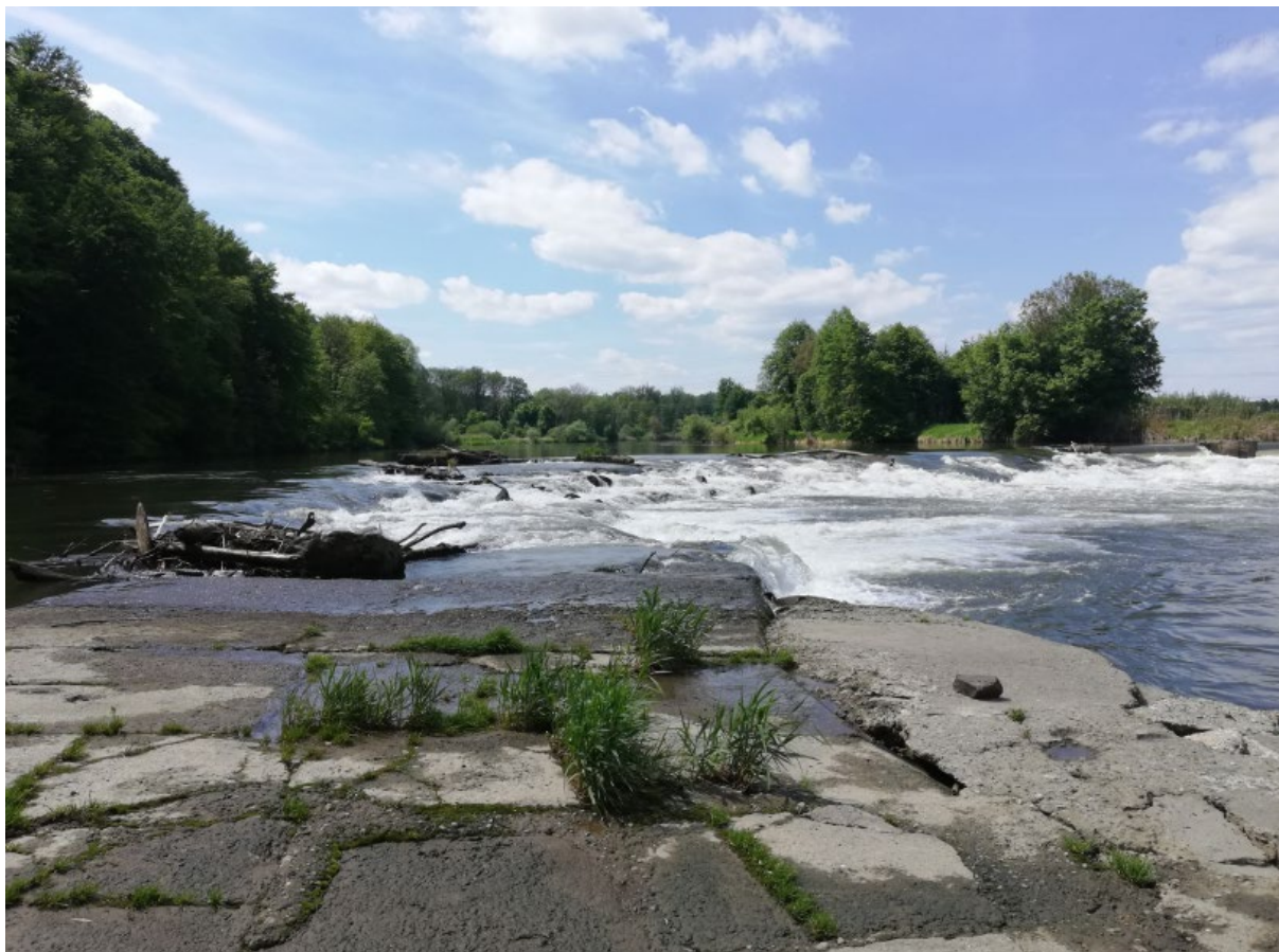
Slika I.12: Ovirana prehodnost za ribe - jez Ceršak (vir: F. Ulaga).
