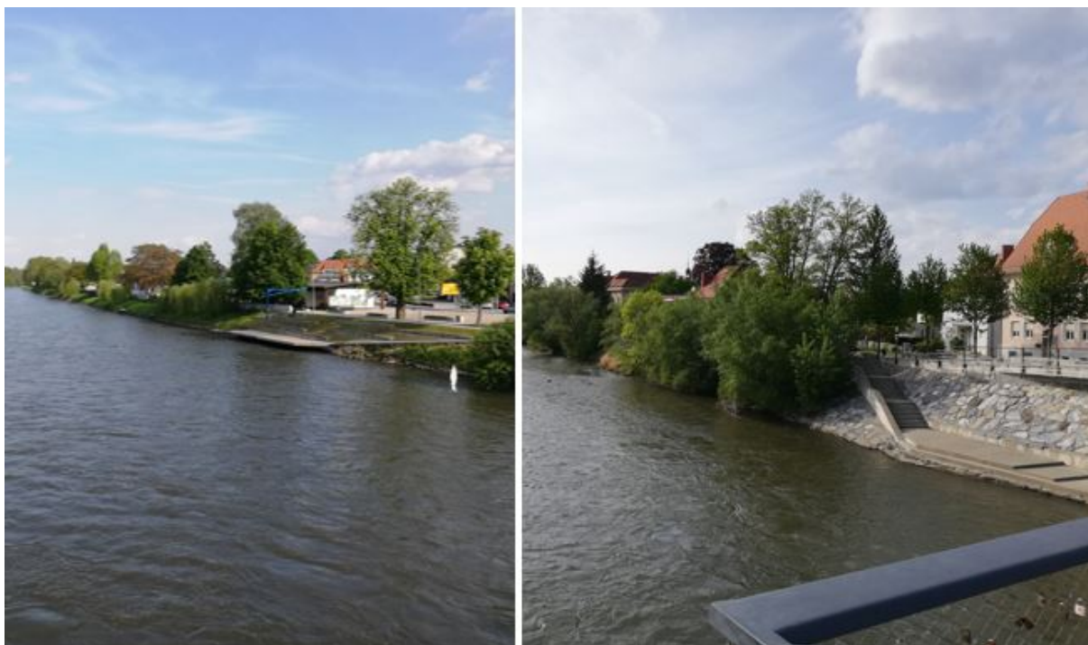
Slika I.11: Togo obrežno zavarovanje na območju Gornje Radgone (levo) in avstrijske Radgone (desno).
