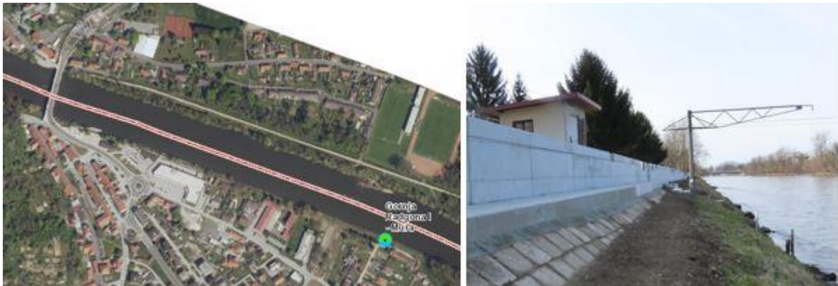
Abb. I.3: Kartographische Darstellung des Standorts der Pegelmessstation Gornja Radgona I (links) (Quelle: Atlas okolja, 2020); Pegelmessstation Gornja Radgona I nach der Sanierung der Hochwassermauer (rechts) (Quelle: Arhiv ARSO, 2020).
