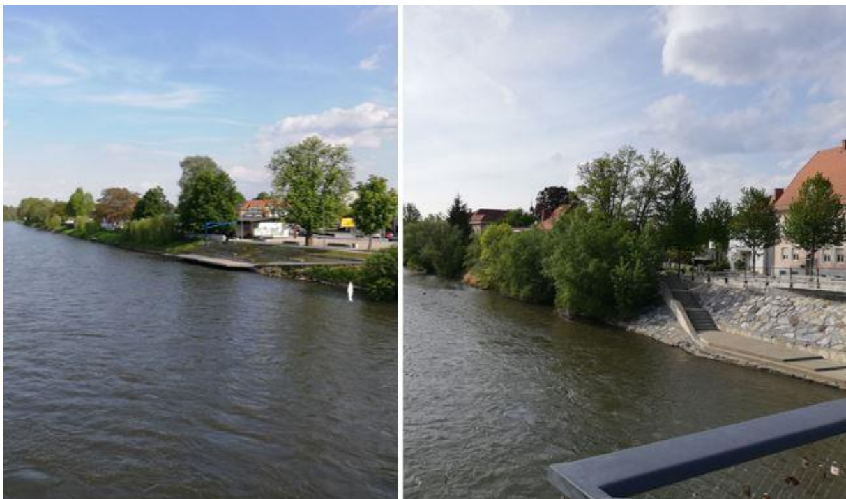
Abb. I.30: Starre Ufersicherung im Gebiet Gornja Radgona (links) und Bad Radkersburg (rechts).
